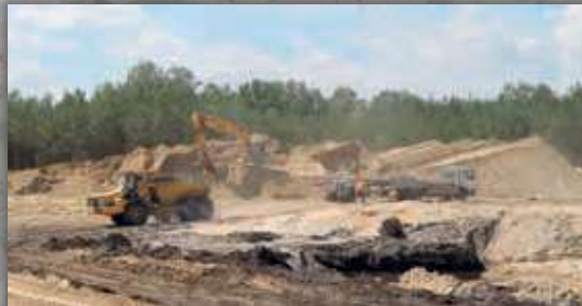
Budowa drogi ekspresowej S8
